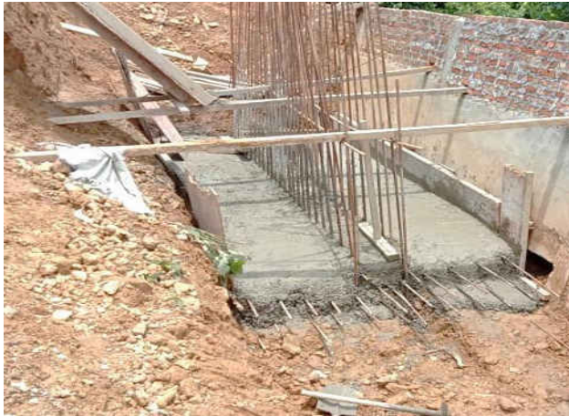
RCC retaining wall at 33/11 kV S. Bungtlang
